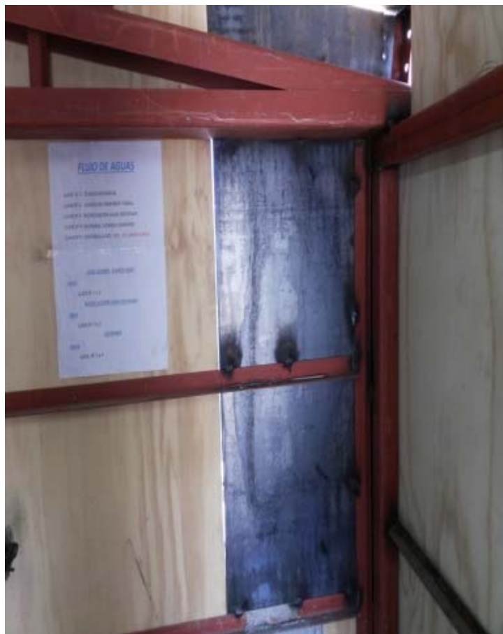
Fotografía N° 3. Instalación de placa metálica en reemplazo de placa de madera.
